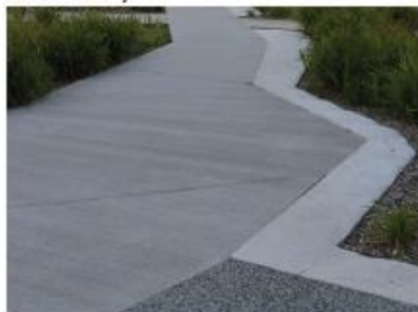
Placette et cheminement piéton en béton balayé
