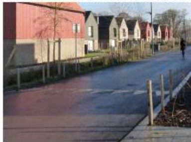
Voirie de desserte locale en enrobé noir
