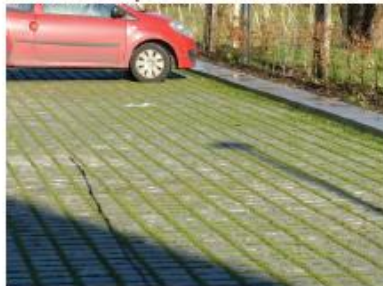
Stationnement en pavés joints gazon pour atténuer l'impact routier de la voirie et limiter l'imperméabilisation des sols
